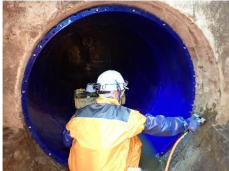
下水道管路の更生工事
