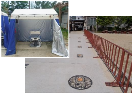
災害用マンホールトイレ （左上は設置時の様子）
