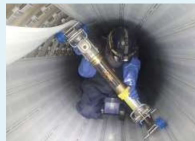
下水道管路の更生工事
