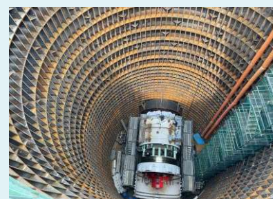
鳥羽第3導水きょ (発進立坑)
