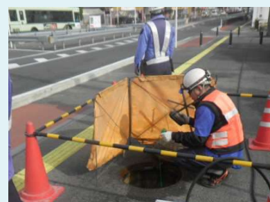
下水道管路の巡視・点検の様子
