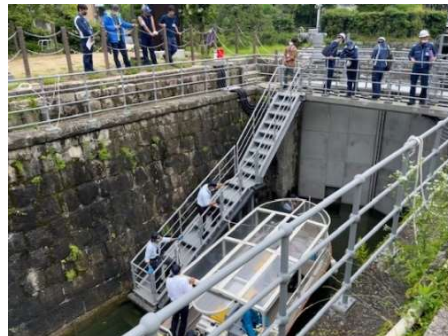
大津閘門開閉訓練
