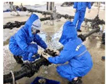
水道技術研修施設での研修 （水道管修繕材料技術研修の様子）
