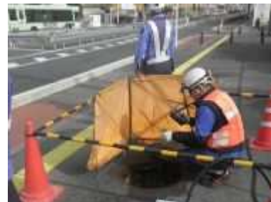
下水道管路の巡視・点検の様子
