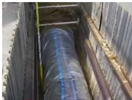
水道配水管の布設替工事
