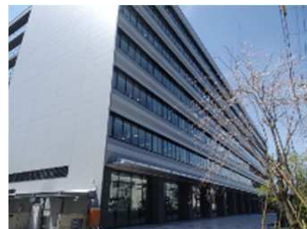
上下水道局総合庁舎
