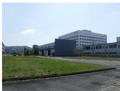
元資器材・防災センター西側用地
