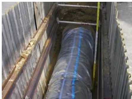
配水管の更新工事
