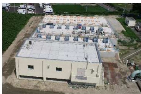
伏見水環境保全センター 分流系最初ちんでん池
