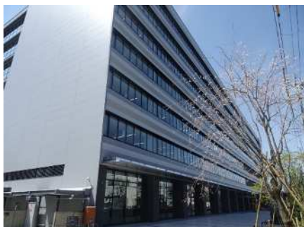
上下水道局総合庁舎
