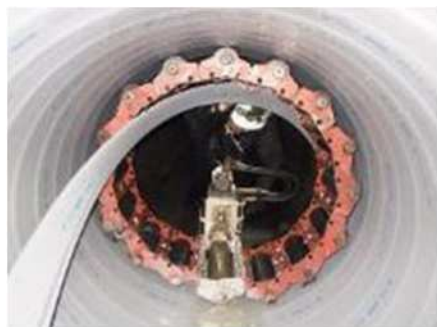
下水道管路の更生工事
