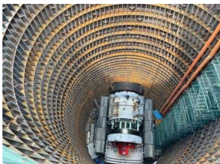
鳥羽第3導水きょ（発進立坑）
