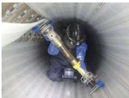
下水道管路の更生工事
