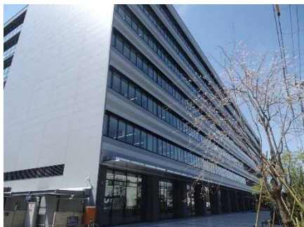
上下水道局総合庁舎
