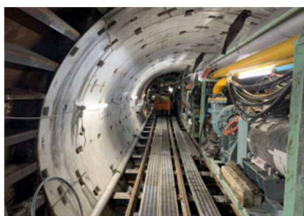
新山科浄水場導水トンネル築造工事 （トンネル掘進の様子）
