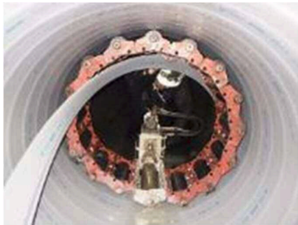
下水道管路の更生工事
