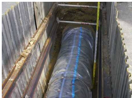
配水管の更新工事
