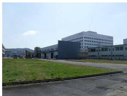
元資器材・防災センター西側用地
