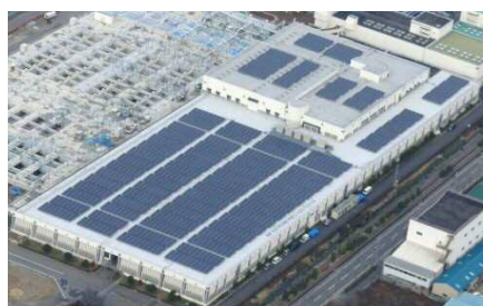
太陽光発電設備 （鳥羽水環境保全センター）
