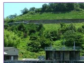
高区配水池 (115.0m)
