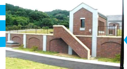
ていくはいすいち 低区配水池
