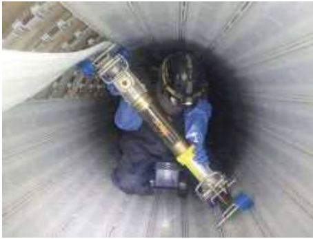
下水道管路の更生工事
