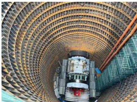
鳥羽第3導水きょ （発進立坑）
