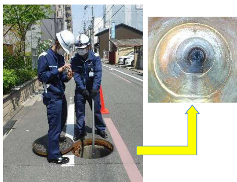
高画質カメラによる調査試行状況
