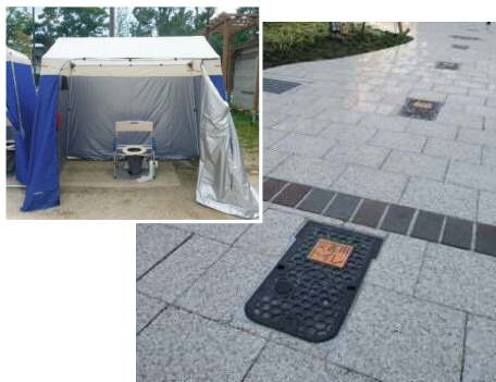
マンホールトイレ （左上は設置時の様子）
