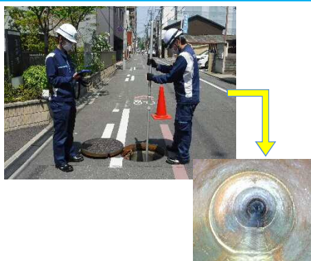
高画質カメラによる調査試行状況
