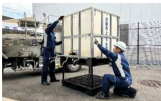
仮設給水槽（組立ての様子）
