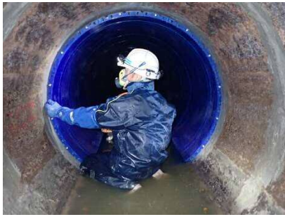
下水道管路の更生工事
