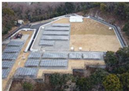
松ヶ崎浄水場 高区1・2号配水池
