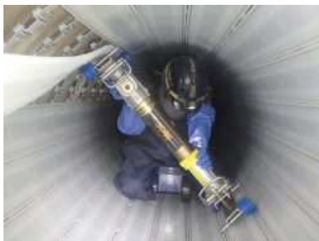
下水道管路の更生工事
