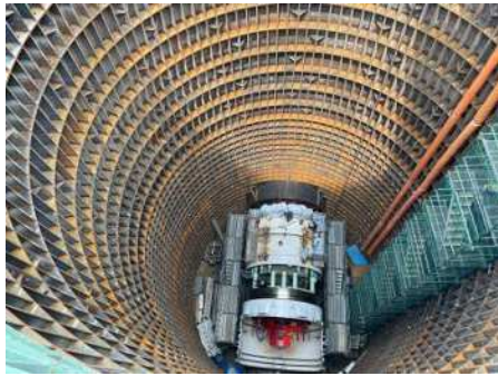
鳥羽第3導水きょ （発進立坑）
