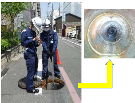
高画質カメラによる調査試行状況
