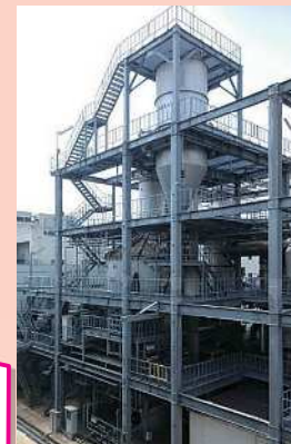
流動床式焼却炉 (鳥羽水環境保全センター)
