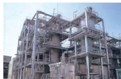
流動床式焼却炉の排煙処理設備
