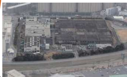
石田水環境保全センター
