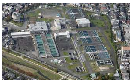
松ヶ崎浄水場
