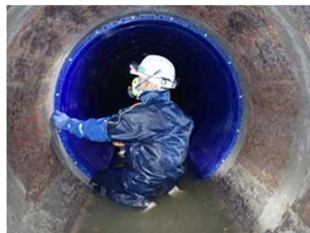
下水道管路の更生工事
