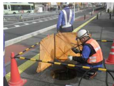
下水道管路の巡視・点検の様子
