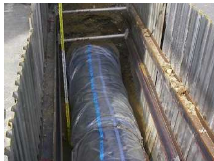
水道配水管の布設替工事
