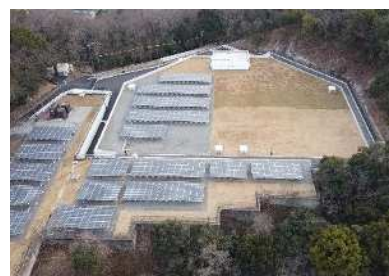
松ヶ崎浄水場 高区1・2号配水池
