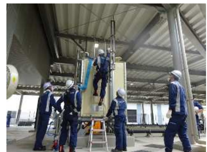
水道技術研修施設での研修 （高所受水槽への補給の様子）
