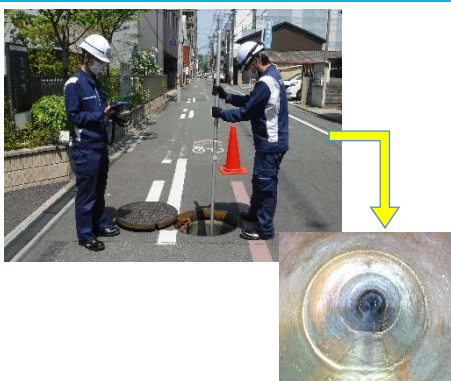
高画質カメラによる調査試行状況
