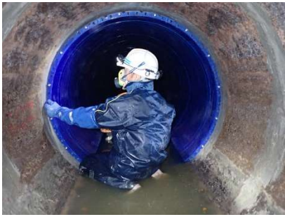
下水道管路の更生工事
