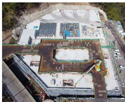
松ヶ崎浄水場 高区1・2号配水池
