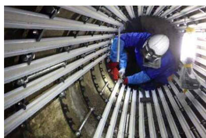
下水道管路の更生工事
