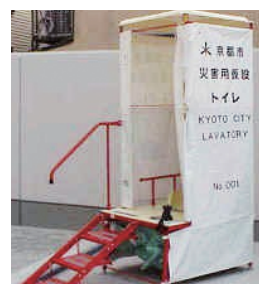
仮設トイレ(貯留式)
