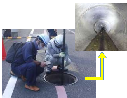
高画質カメラによる調査試行状況
