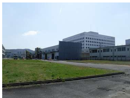
元資器材・防災センター西側用地
