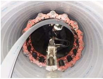
下水道管路の更生工事
