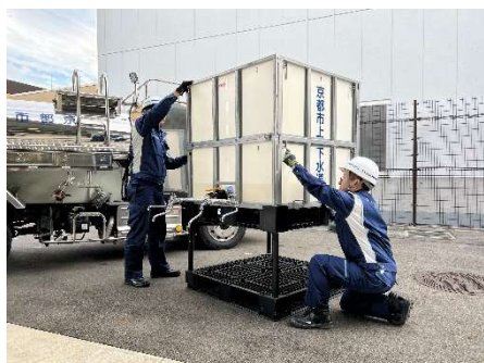
仮設給水槽（組立ての様子）
