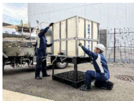
仮設給水槽（組立ての様子）
