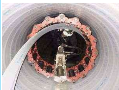
下水道管路の更生工事
