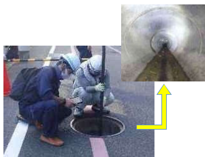
高画質カメラによる調査試行状況
