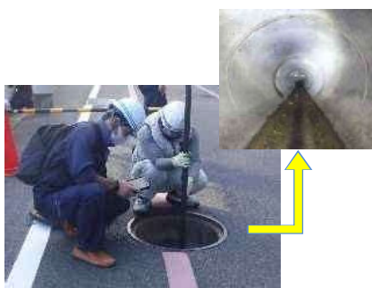
高画質カメラによる調査試行状況
