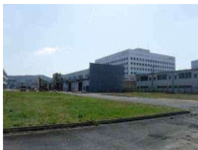
元資器材・防災センター西側用地
