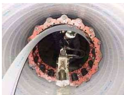
下水道管路の更生工事
