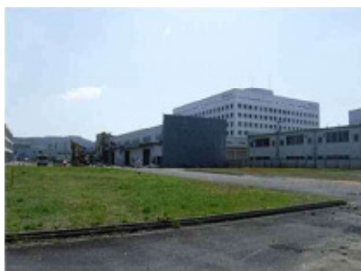
元資器材・防災センター西側用地
