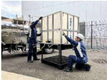
仮設給水槽（組立ての様子）
