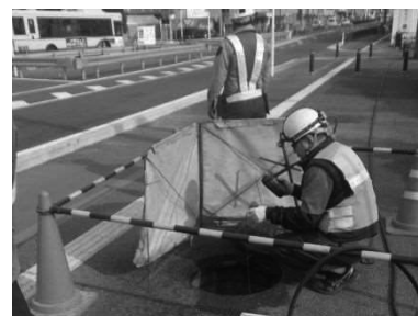
下水道管路の巡視・点検の様子
