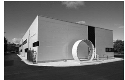
下水道技術研修施設
