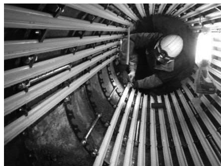
下水道管路の更生工事
