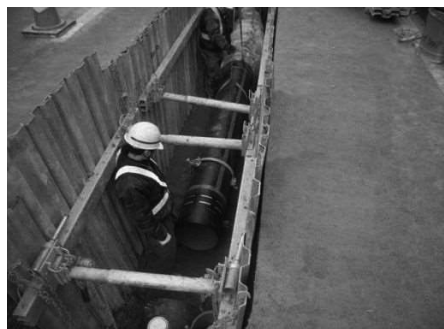
水道配水管の布設替工事
