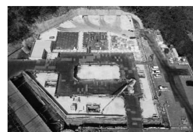
配水池更新工事
