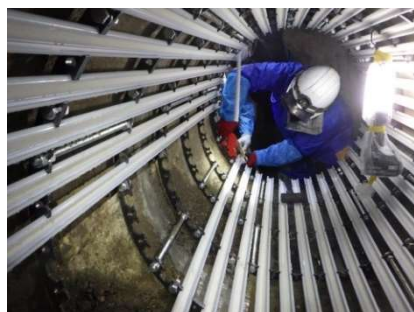
下水道管路の更生工事
