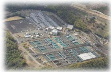
新山科浄水場
