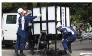
仮設給水槽（組立ての様子）
