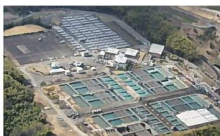
③ 新山科浄水場
