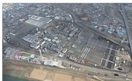
④ 鳥羽水環境保全センター
