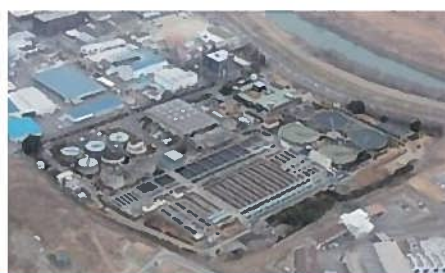
⑥ 伏見水環境保全センター
