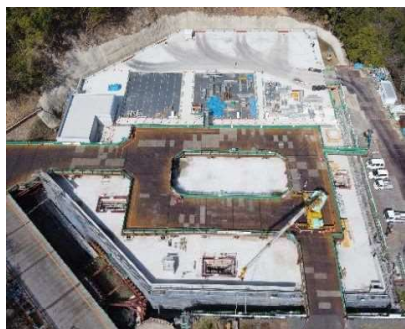
松ヶ崎浄水場 高区 1・2 号配水池
