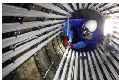
下水道管路の更生工事
