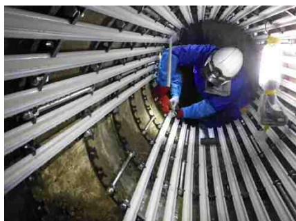
下水道管路の更生工事
