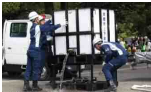
仮設給水槽（組立ての様子）
