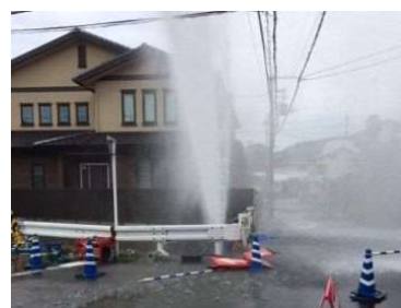
老朽化による漏水の様子
