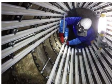
下水道管路の更生工事
