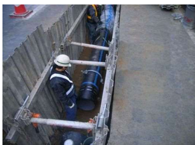
水道配水管の布設替工事
