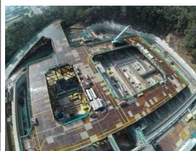
配水池更新工事
