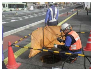
下水道管路の巡視・点検の様子
