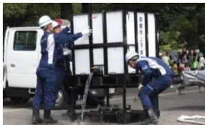
仮設給水槽（組立ての様子）
