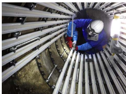
下水道管路の更生工事
