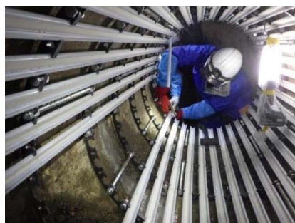
下水道管路の更生工事
