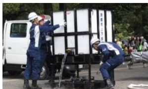
仮設給水槽（組立ての様子）
