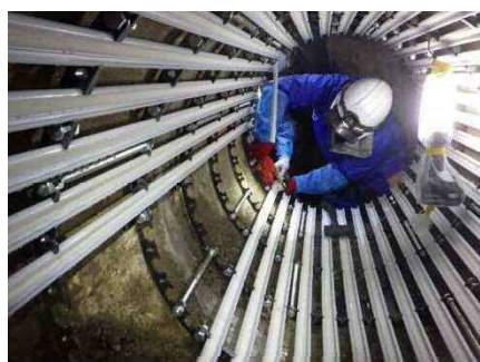
下水道管路の更生工事
