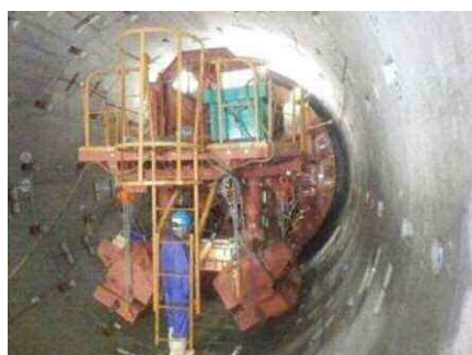
施工中の雨水幹線の内部
