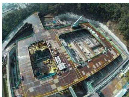
配水池更新工事
