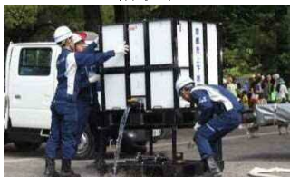
仮設給水槽（組立ての様子）
