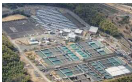
③ 新山科浄水場
