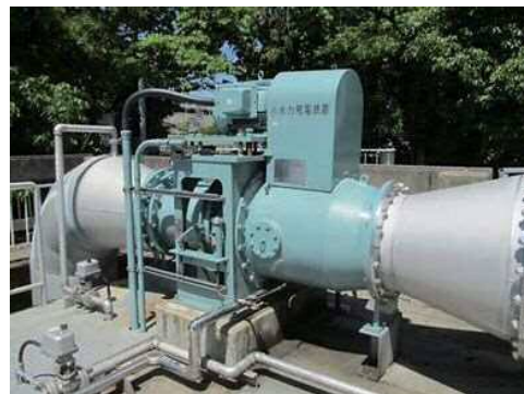
小水力発電設備（石田水環境保全センター） 定格出力：9 kW 発電実績：81,480 kWh（令和元年度）
