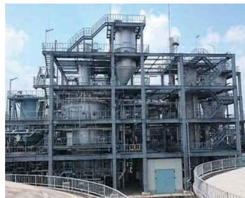
流動床式焼却炉(鳥羽水環境保全センター)
