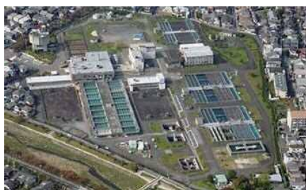
② 松ヶ崎浄水場
