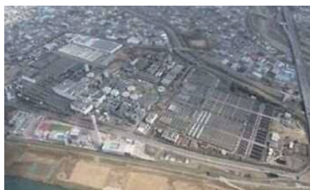
④ 鳥羽水環境保全センター
