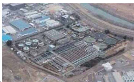
⑥ 伏見水環境保全センター
