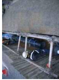
水道配水管の布設替工事
