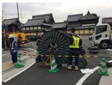
下水道管更生の施工状況
