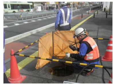
下水道管路の巡視・点検の様子
