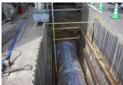
水道配水管の布設替工事
