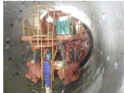
施工中の雨水幹線の内部
