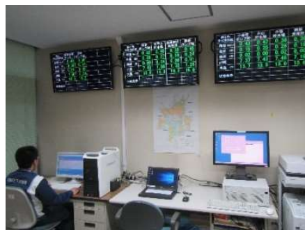
水質監視装置 監視画面
