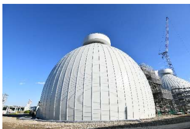
汚泥消化タンク（鳥羽水環境保全センター）
