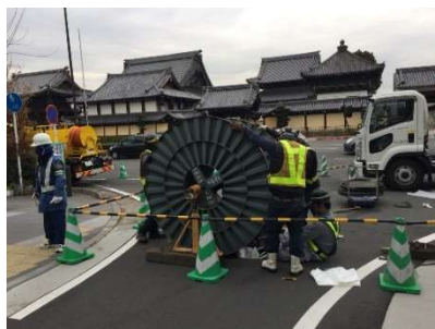
下水道管更生の施工状況
