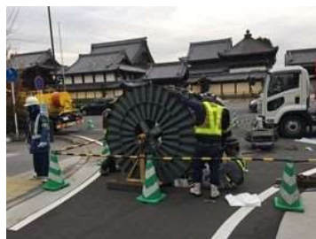
下水道管路の更生工事の様子
