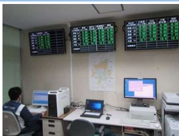
水質自動監視装置の監視画面
