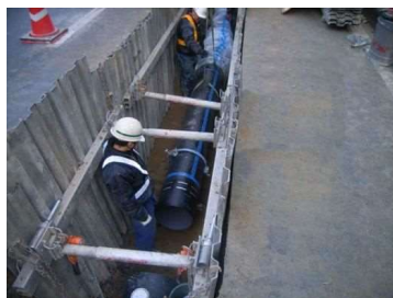
配水管工事の様子
