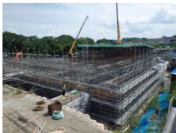
下水処理施設の改築工事の様子
