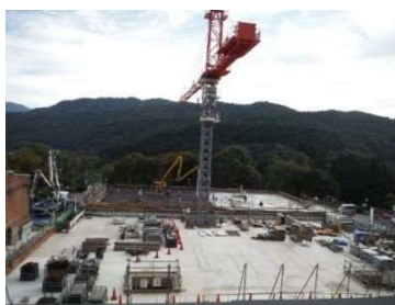
配水池更新工事の様子
