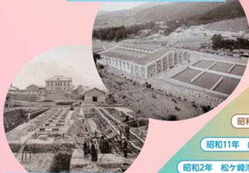
京都市水道浄水地(蹴上浄水場)の建設工事(明治43年6月撮影)
