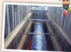
水道耐震管の布設
