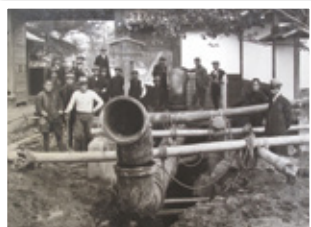
知恩院南門前配水管布設工事の様子
