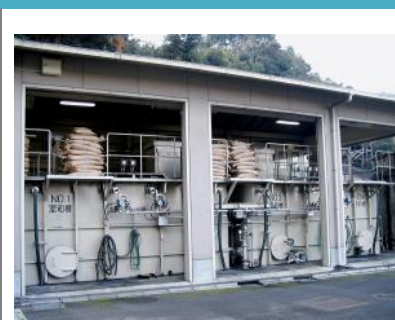
現在の粉末活性炭注入設備
