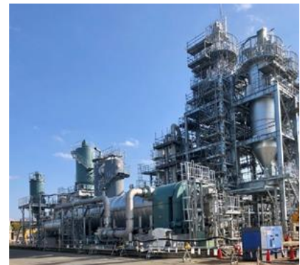
鳥羽水環境保全センター固形燃料化施設
