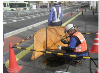
下水道管路の巡視・点検の様子
