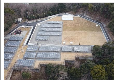
松ヶ崎浄水場 高区1・2号配水池
