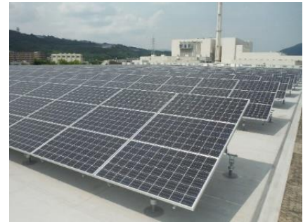
石田水環境保全センターの太陽光発電設備
