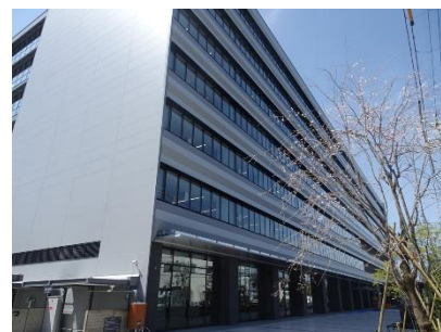
南部拠点（総合庁舎）
