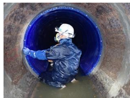
下水道管路の更生工事
