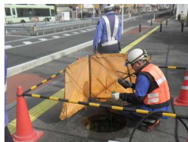
下水道管路の巡視・点検の様子
