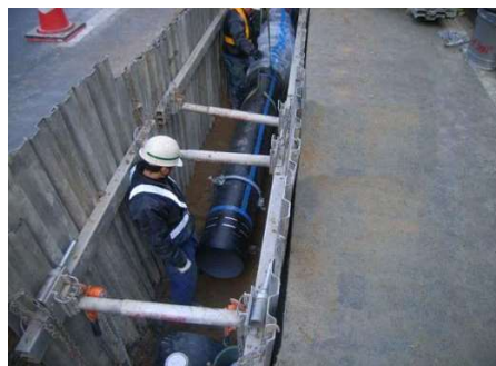
水道配水管の布設替工事
