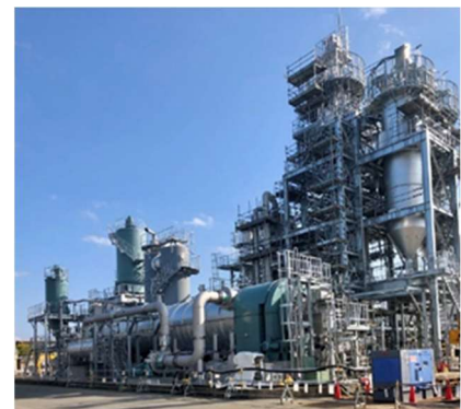
鳥羽水環境保全センター固形燃料化施設 (令和3年3月末完成)
