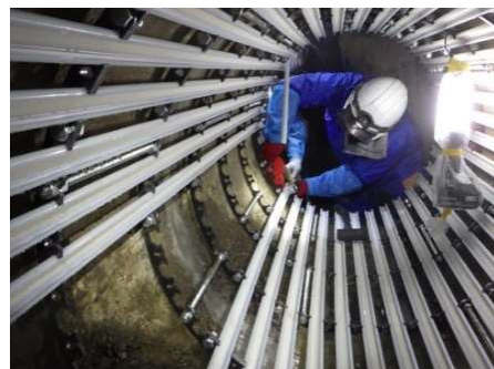
下水道管路の更生工事
