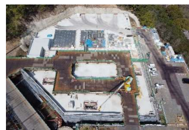
配水池更新工事
