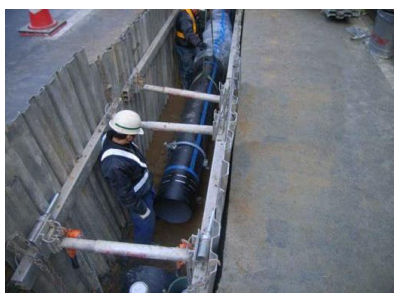
水道配水管の布設替工事
