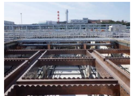
伏見水環境保全センター最終ちんでん池
