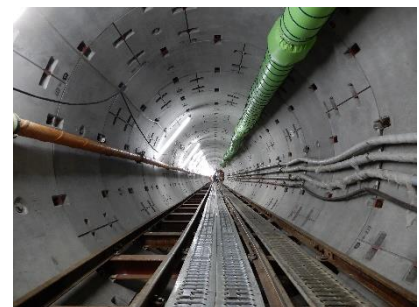
施工中の津知橋幹線
