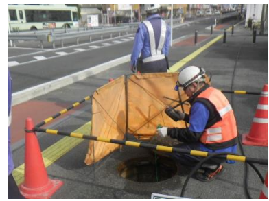
下水道管路の巡視・点検の様子
