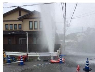
老朽化による漏水の様子
