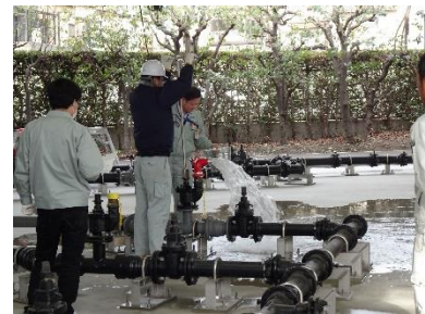
水道技術研修施設での他都市モニター研修
