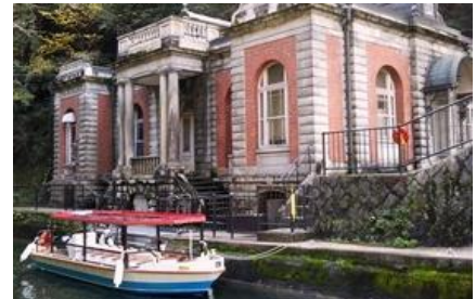
旧御所水道ポンプ室と新船「れいわ号」
