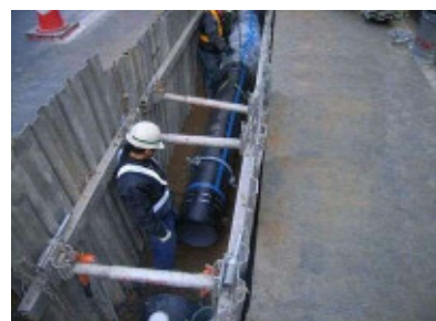
水道配水管の布設替工事
