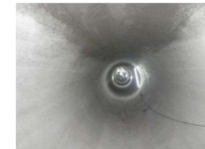
完成した雨水幹線内部（山科川13-1号幹線）
