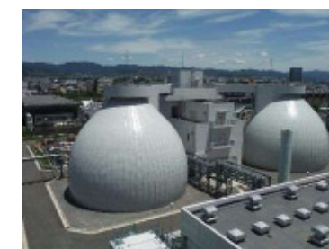
汚泥消化タンク（鳥羽水環境保全センター）
