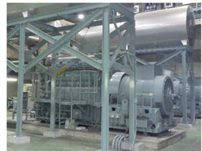
自家発電設備（石田水環境保全センター）
