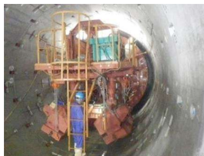
施工中の雨水幹線の内部
