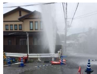
老朽化による漏水の様子
