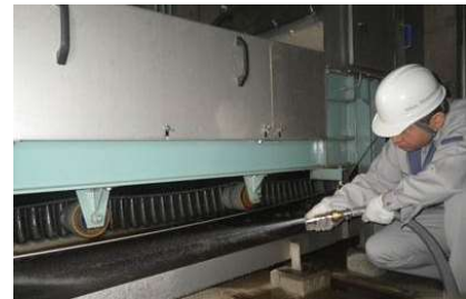
水環境保全センターにおける保守点検の様子
