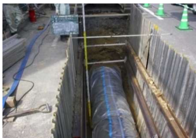
水道配水管の布設替工事
