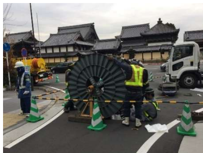
下水道管更生の施工状況
