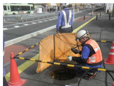
下水道管路の巡視・点検の様子
