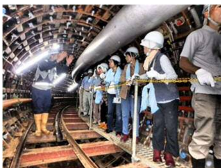
（施工中の雨水幹線の内部（施設見学会））
