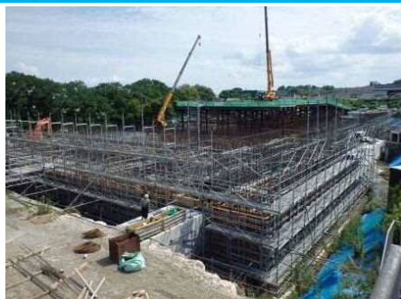
(下水処理施設の改築工事の様子)
