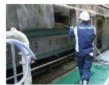
施設の点検・洗浄
