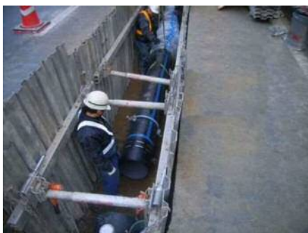
（配水管工事の様子）
