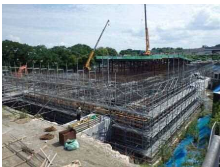
（下水処理施設の改築工事の様子）
