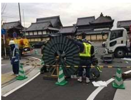
（下水道管路の更生工事の様子）
