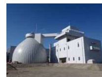
汚泥消化タンク
