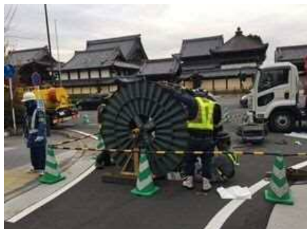
(下水道管路の更生工事の様子)
