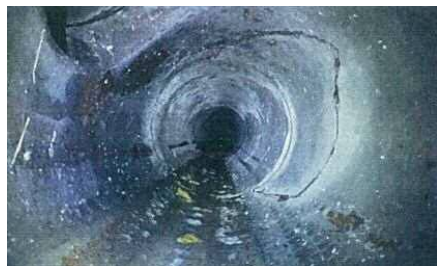
（管路内調査画像（下水道））
