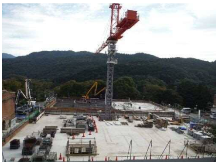
（配水池更新工事の様子）
