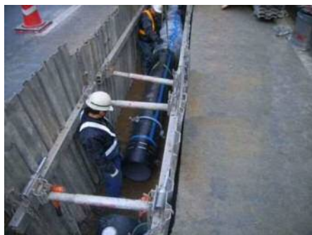
(配水管工事の様子)
