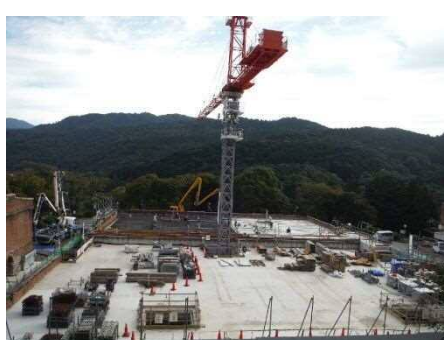
（配水池更新工事の様子）
