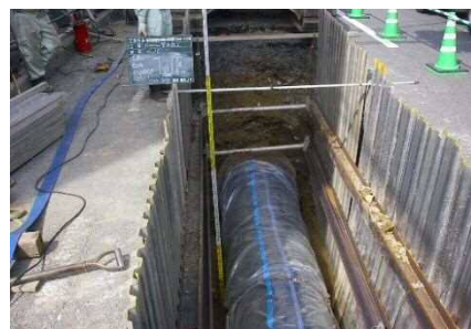
配水管の布設替工事
