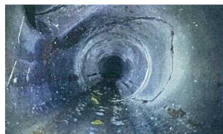
（管路内調査画像（下水道））
