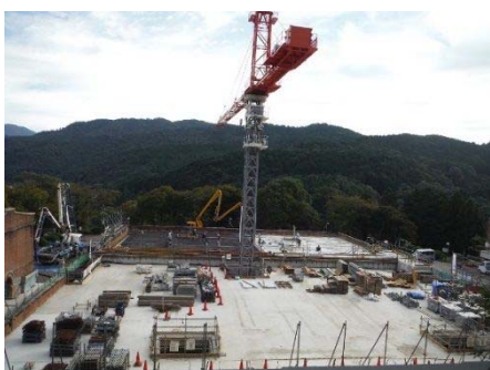
（配水池更新工事の様子）
