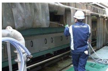
(水環境保全センターにおけるベルトコンベアの点検・洗浄)
