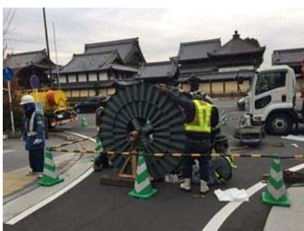
（下水道管路の更生工事の様子）
