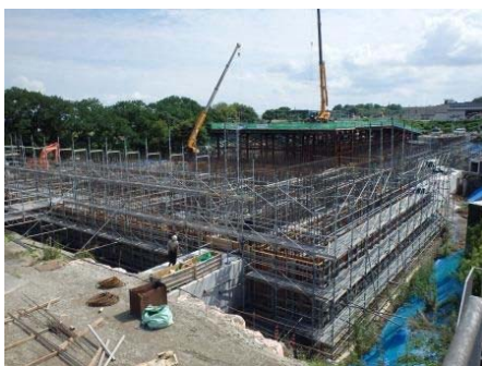
（下水道施設の改築工事の様子）
