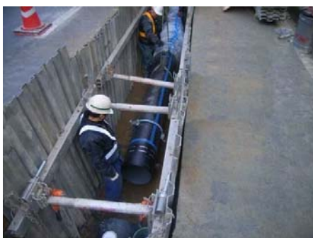
（配水管工事の様子）
