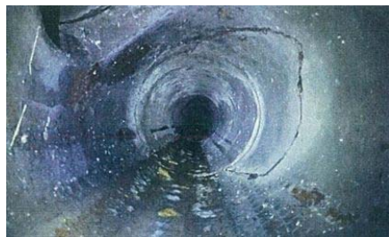
（管路内調査画像（下水道））
