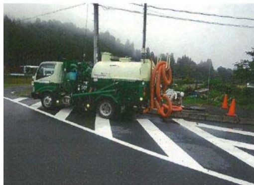
バキューム車による浚渫作業（右京区京北）
