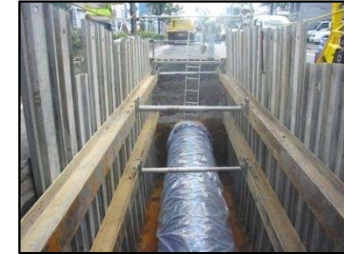
老朽化した水道管の更新
