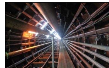
整備中の雨水幹線(新川6号幹線)
