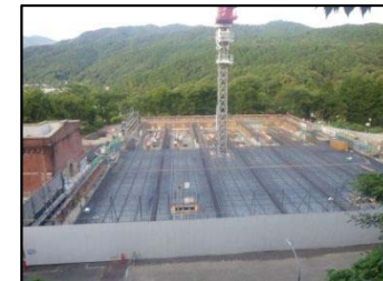
第1高区配水池（蹴上浄水場）の更新
