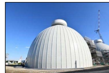
汚泥消化タンク
