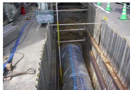
配水管の布設替工事
