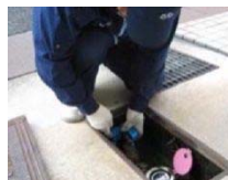
水道開閉栓作業
