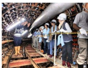
施工中の雨水幹線(施設見学会)
