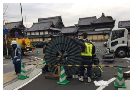
下水道管更生の施工状況
