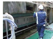
施設の点検・洗浄
