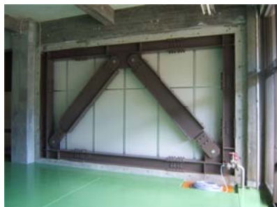
浄水場管理棟の耐震化
