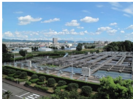
鳥羽水環境保全センター
