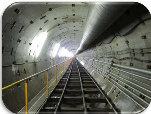
整備中の下水道雨水幹線
