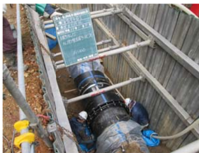
水道管路の耐震化
