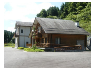
京北浄化センター
