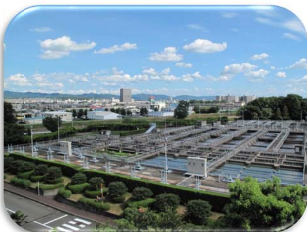
鳥羽水環境保全センター
