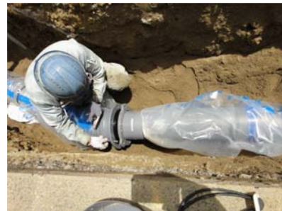
100年管を使用した水道管の布設替え (長寿命化と防災・減災機能の向上)
