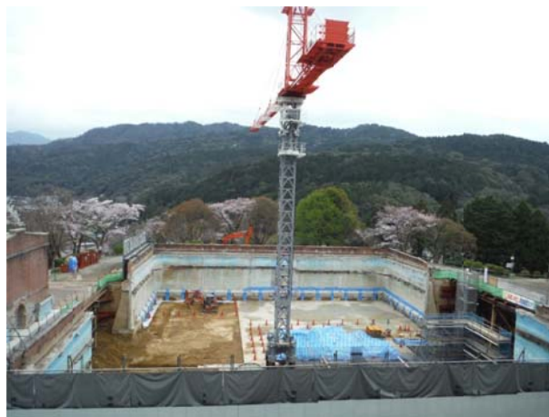
既存の水道施設（配水池）の壁を利用した施設更新 （施設の有効利用）
