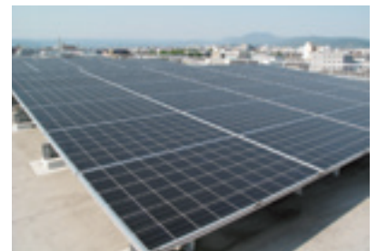
太陽光発電設備
