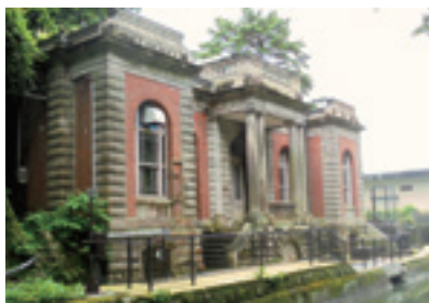
旧御所水道ポンプ室
