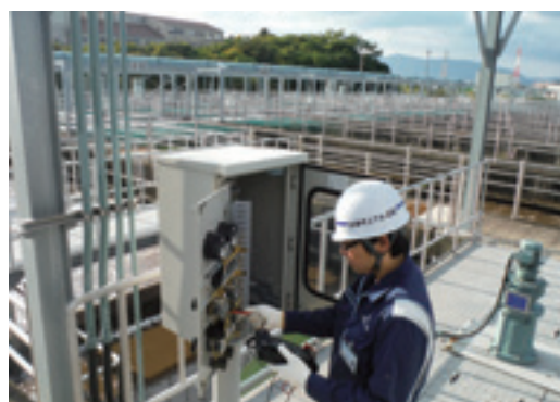
処理設備の点検状況
