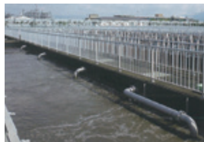
下水道の水処理技術の調査研究
