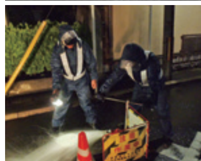
「京（みやこ）の水道管おそうじプロジェクト」における水道管洗浄作業の様子
