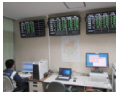
水質監視装置 監視画面
