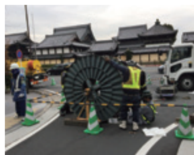
下水道管更生の施工状況
