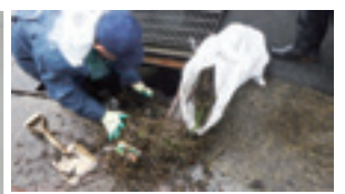
側溝・雨水ます清掃
