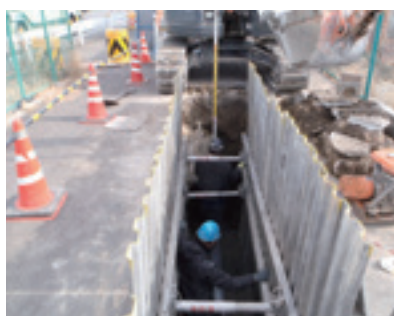
下水道管布設替えの施工状況
