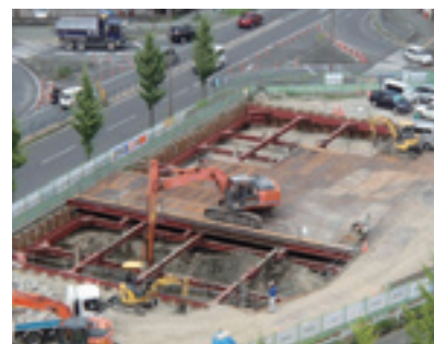
雨水調整池の施工状況
