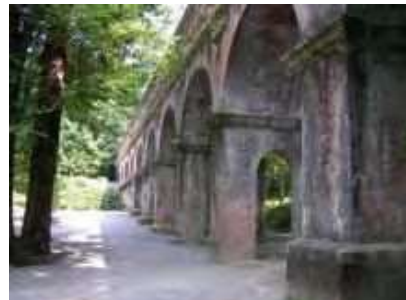
【琵琶湖疏水（疏水分線の水路閘）】 （京都府京都市左京区）
