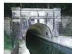
⑥ 第5トンネル入口部分
