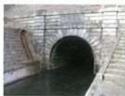
⑤ 第4トンネル出口部分
