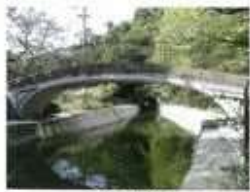
⑨ 山ノ谷橋
