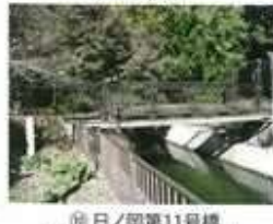
⑩ 日ノ岡第11号橋 (本邦最初鉄筋混凝土橋)
