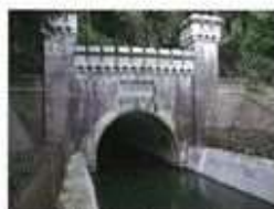
⑧ 第7トンネル入口部分
