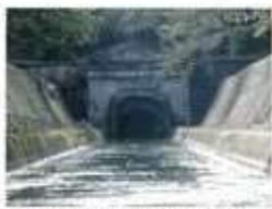
① 第1トンネル入口部分
