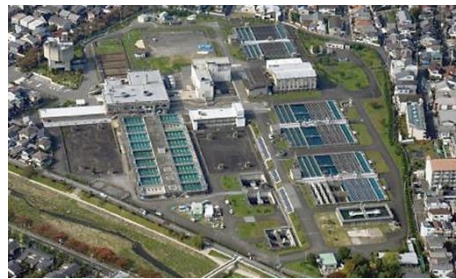
松ヶ崎浄水場
