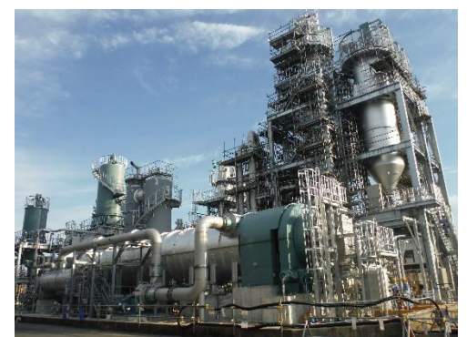
下水汚泥固形燃料化炉(鳥羽水環境保全センター)
