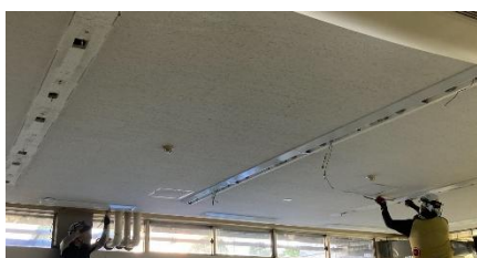
照明設備のLED化工事(水質管理センター水質第2課)
