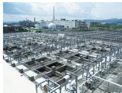
高度処理施設(鳥羽水環境保全センター)
