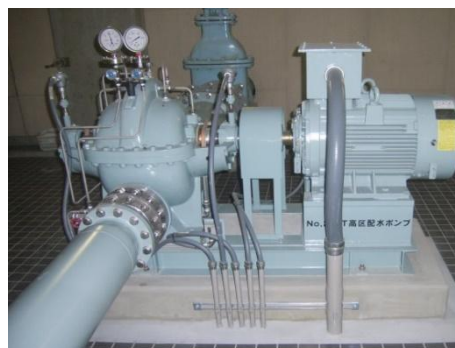
インバータ制御方式のポンプ インバータ制御によりポンプの流量を調整することで、効率の良い運転を行うことができます。
