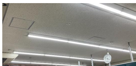
照明設備のLED化工事(水質管理センター水質第2課)
