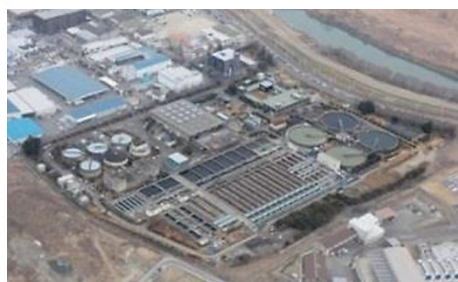
伏見水環境保全センター
