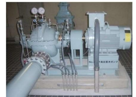
インバータ制御方式のポンプ
